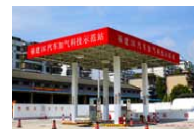
Автомобильные заправочные станции СПГ LNG vehicle refueling station
