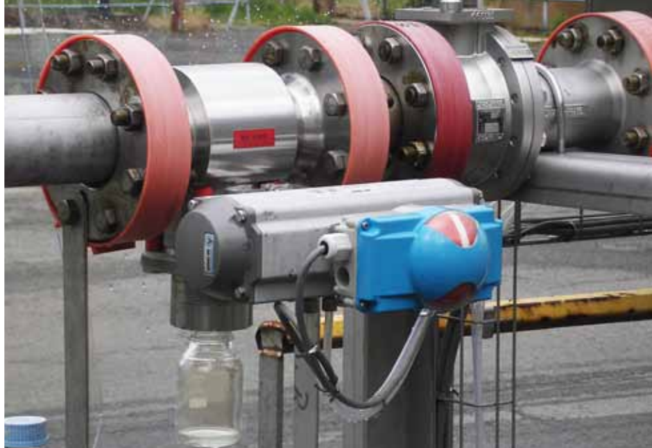
Стальное приспособление для взятия проб для контроля качества
