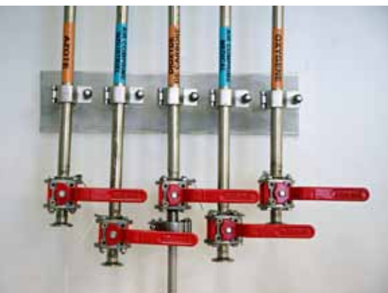
Вентили со сварным и клеммовым соединением, установленные в исследовательских лабораториях
