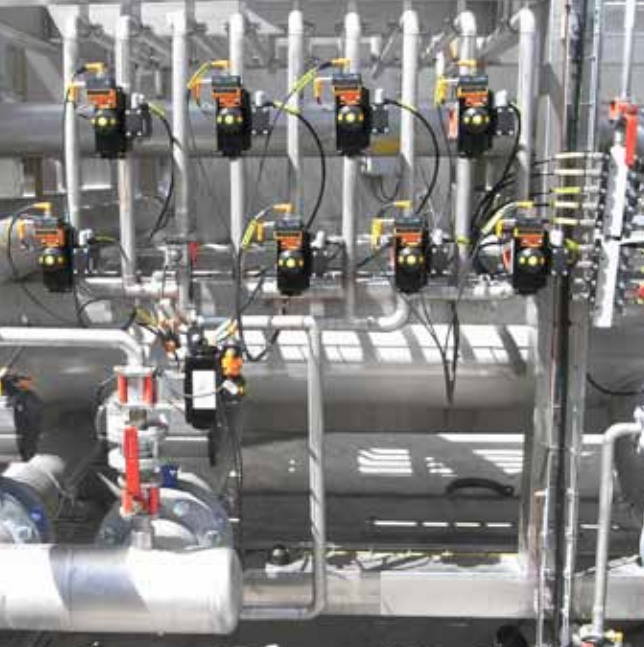
Автоматизированные вентили для агрохимического оборудования
