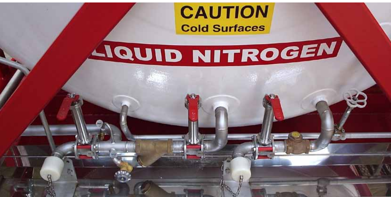
Криогенные вентили, установленные на передвижных резервуарах
