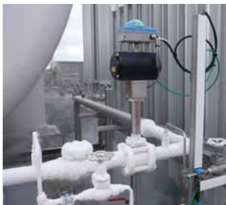
Криогенный вентиль, установленный на резервуаре с жидким азотом
